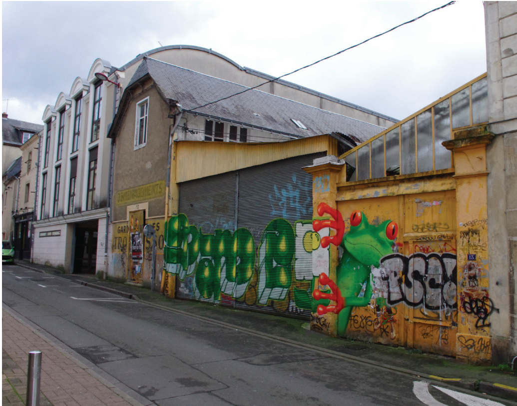
Le 13 rue de la Barillerie avant les travaux.
