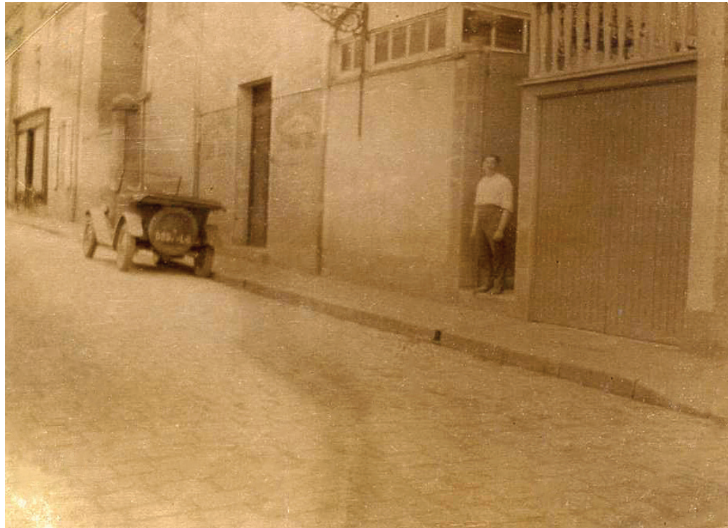
Avant l'entreprise Troncosso, rue de la Barillerie.
