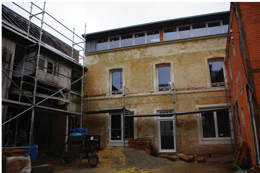
Agence d'architecture Ledru en travaux.
